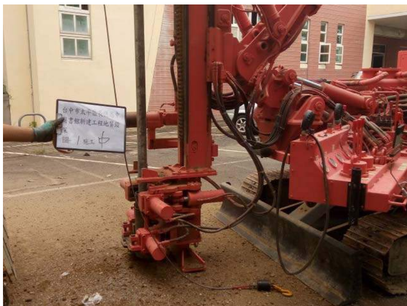
圖書館 BH-1 施工中
