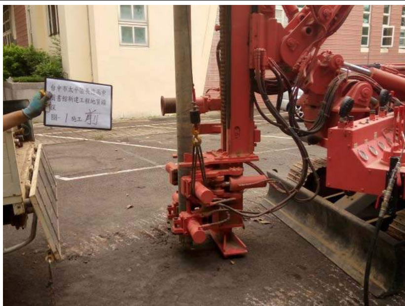
圖書館 BH-1 施工前
