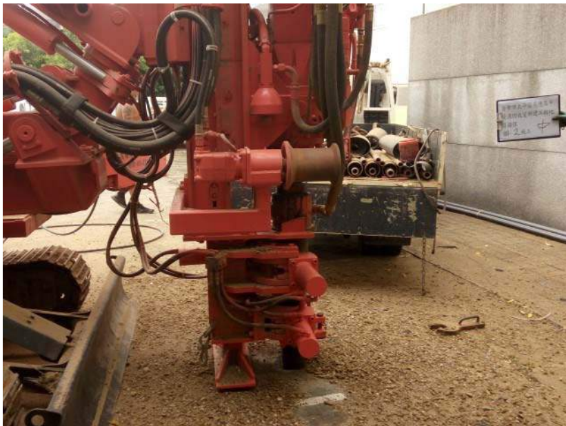
資源回收 室 BH-2 施工中
