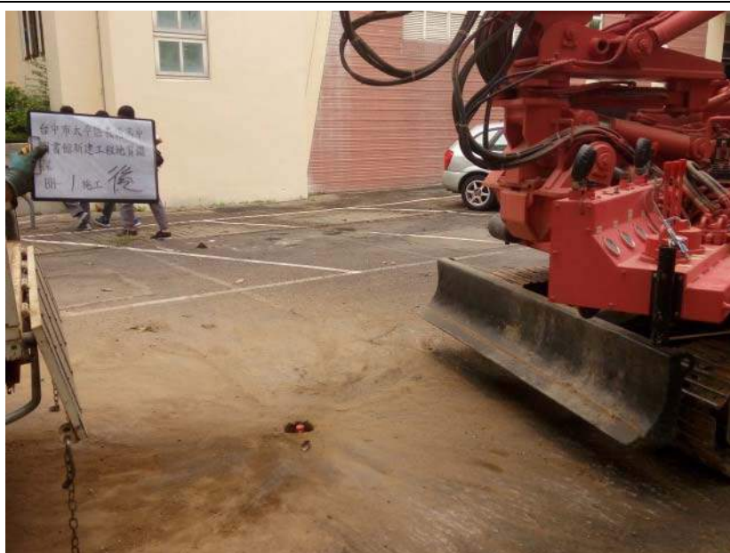
圖書館 BH-1 施工後
