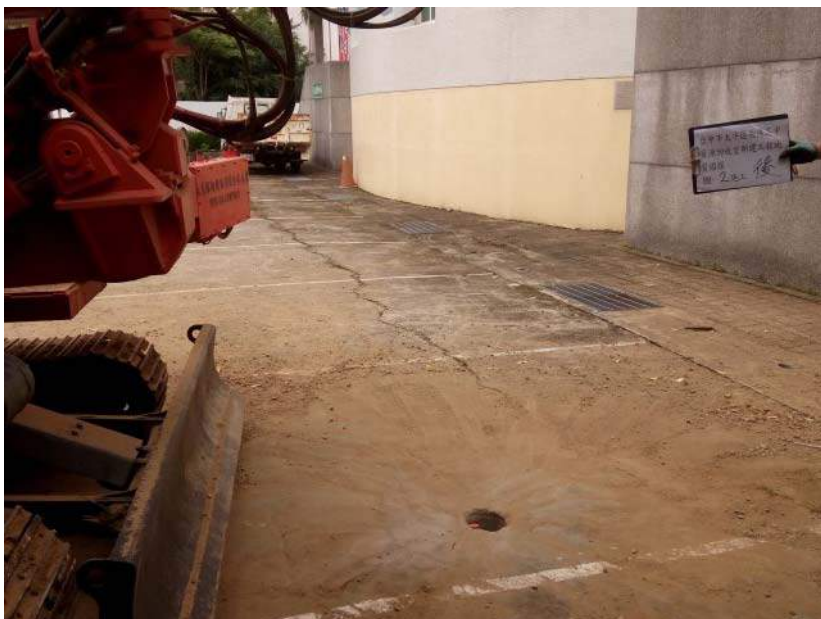
資源回收 室 BH-2 施工後
